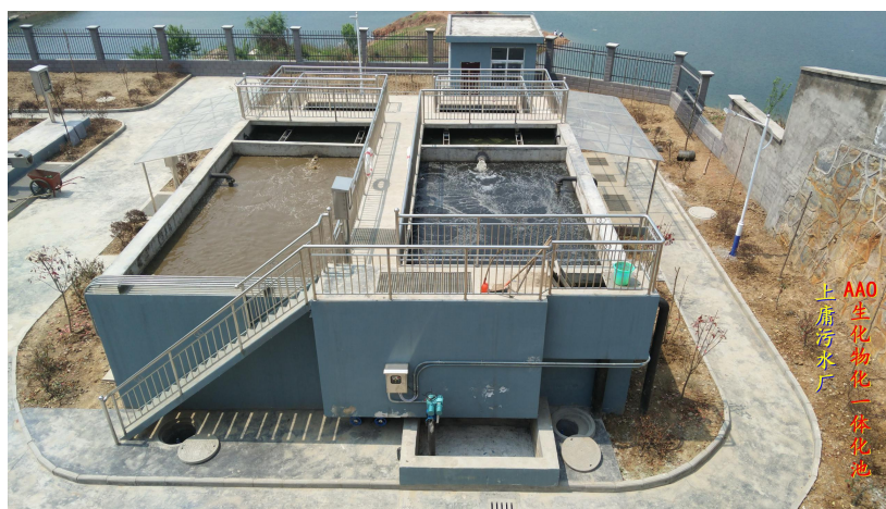
上庸污水厂——AAO生物物化一体化池
