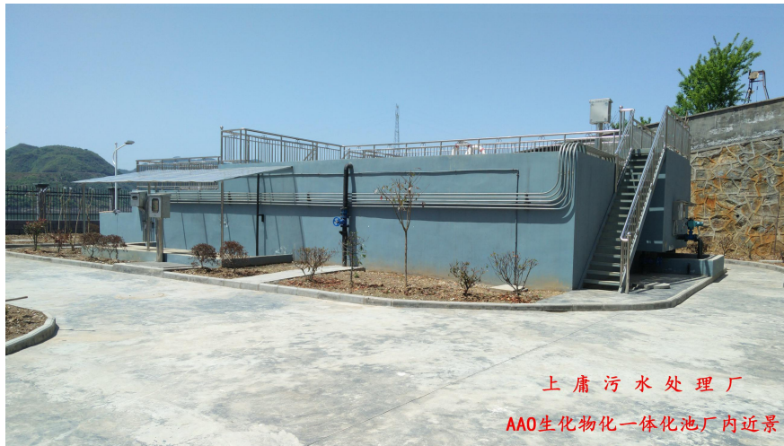
上庸污水厂——AAO生物物化一体化池
