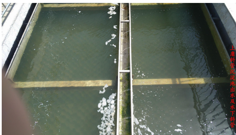
上庸污水厂——AAO生化池、二沉池与深度处理的斜管沉淀池一体化设计
