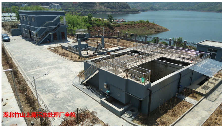
湖北省上庸污水处理厂全貌（右上为河道型潘口水库）
