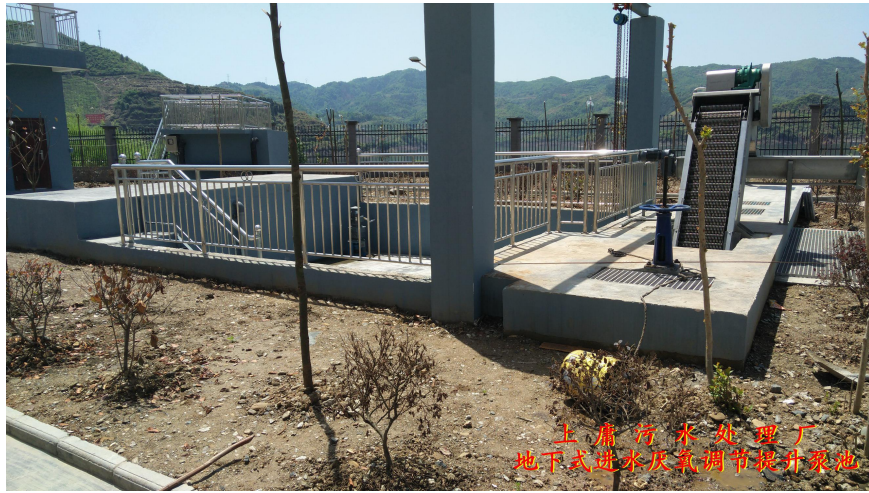
上庸污水厂——地下式进水调节提升泵池
