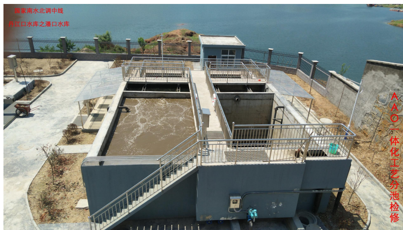
上庸污水厂——AAO一体化池可分池检修
