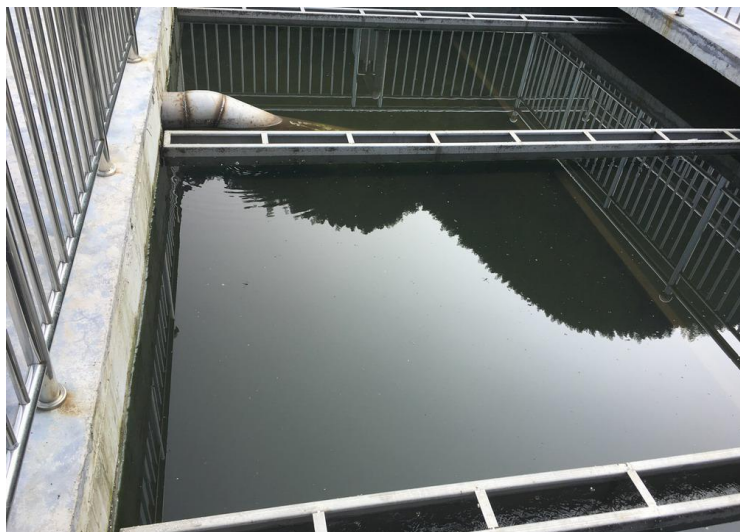
黄山汤口污水厂——AAO一体化池二沉池（悬浮澄清池型，污泥气提回流）
