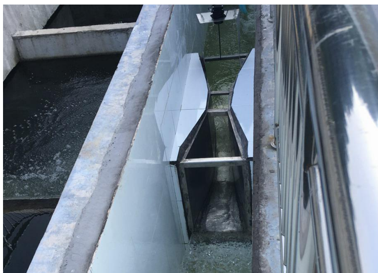
黄山汤口污水厂——AAO一体化池的接触消毒池（左）、出水巴氏计量监测渠
