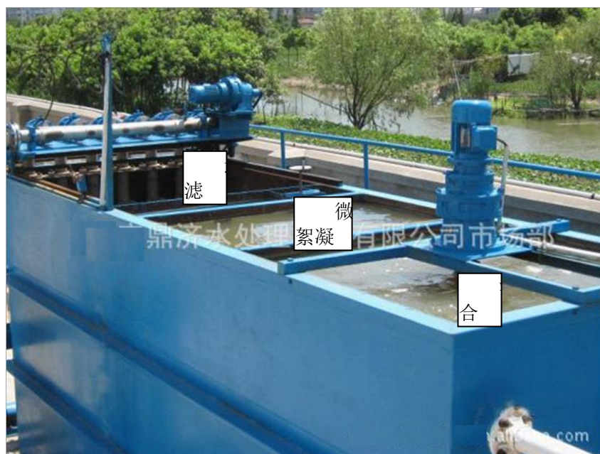
图 2-8：IBR 后续加药混合+微絮凝+纤维滤布转盘过滤成套装置
