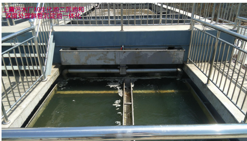
上庸污水厂——AAO生化池、二沉池与深度处理的斜管沉淀池一体化设计
