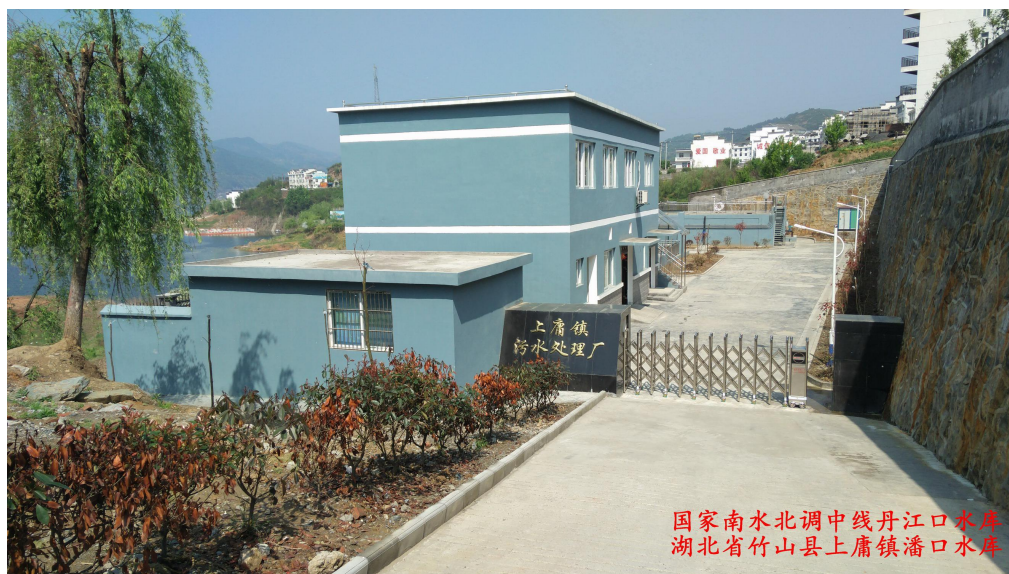
实际案例——湖北省上庸镇污水处理厂照片
