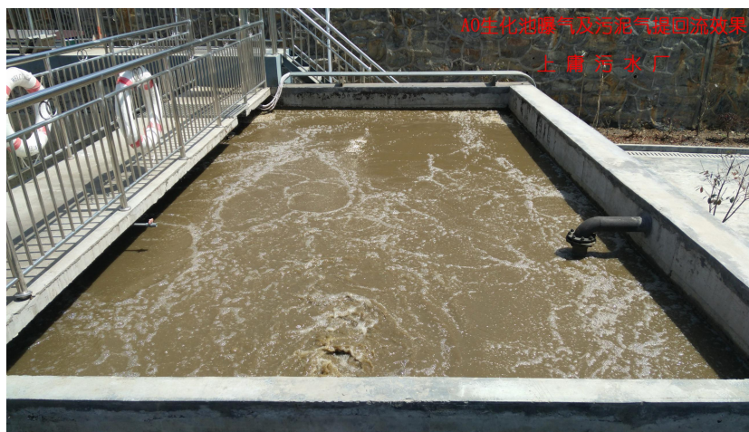
上庸污水厂——A0生化池及污泥气提回流效果
